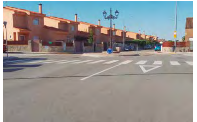
Nuevo asfaltado y señalización vial
