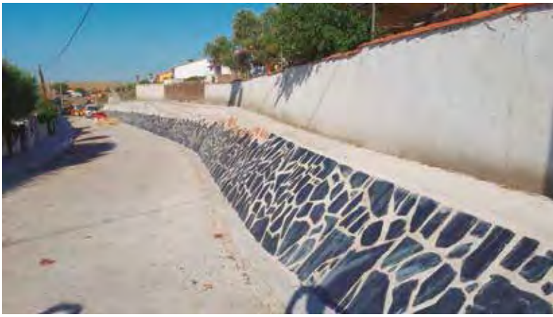
Parapeto de contención de tierras en el paseo del Encinar
