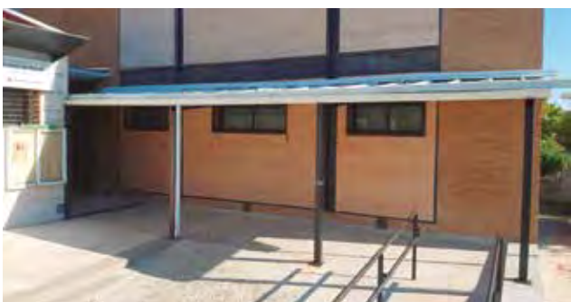
Nuevo porche del Centro de Salud
