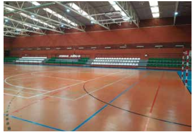
Instalación de butacas en las gradas del Pabellón del IES
