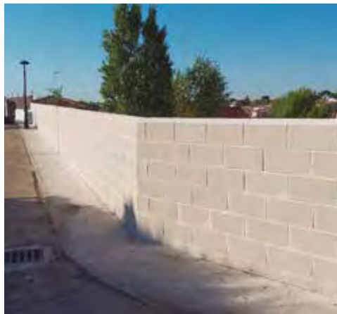
Nuevo muro estético de seguridad de la Calle Mirador
