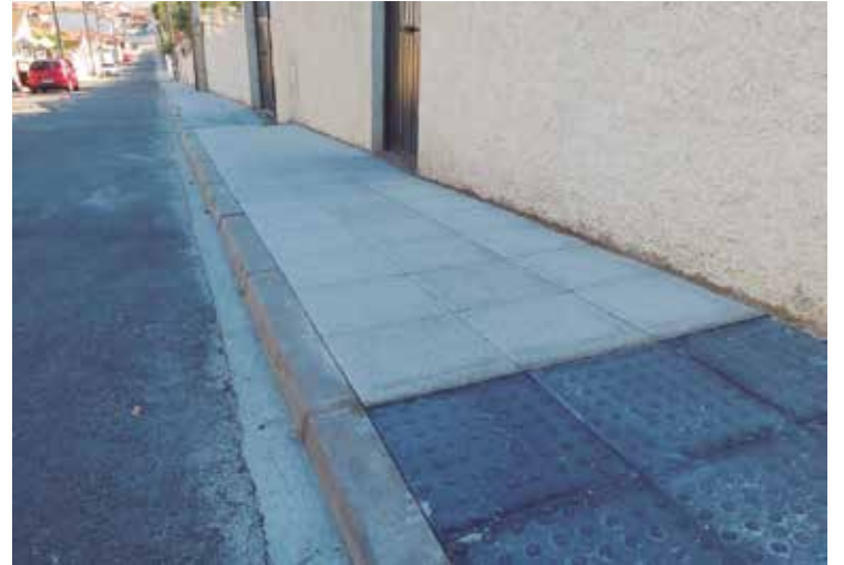
Nuevo acerado en la calle Hortensias
