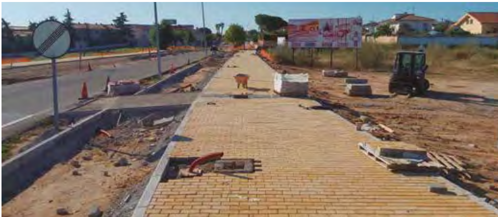
Obras a buen ritmo en el acceso norte del municipio
