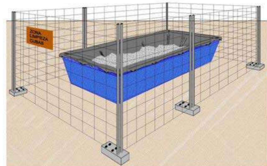
ZONA HABILITADA PARA LIMPIEZA DE CUBAS DE HORMIGÓN
