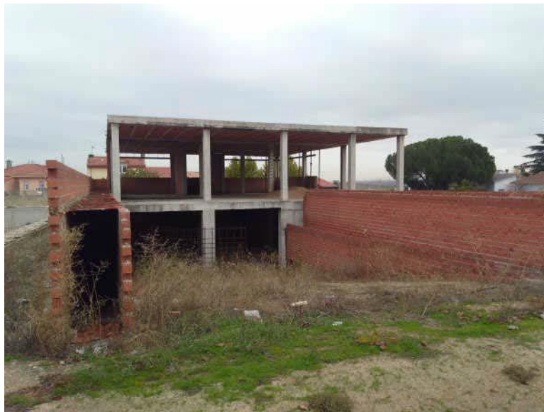
Ilustración 3. Imagen de la construcción paralizada
