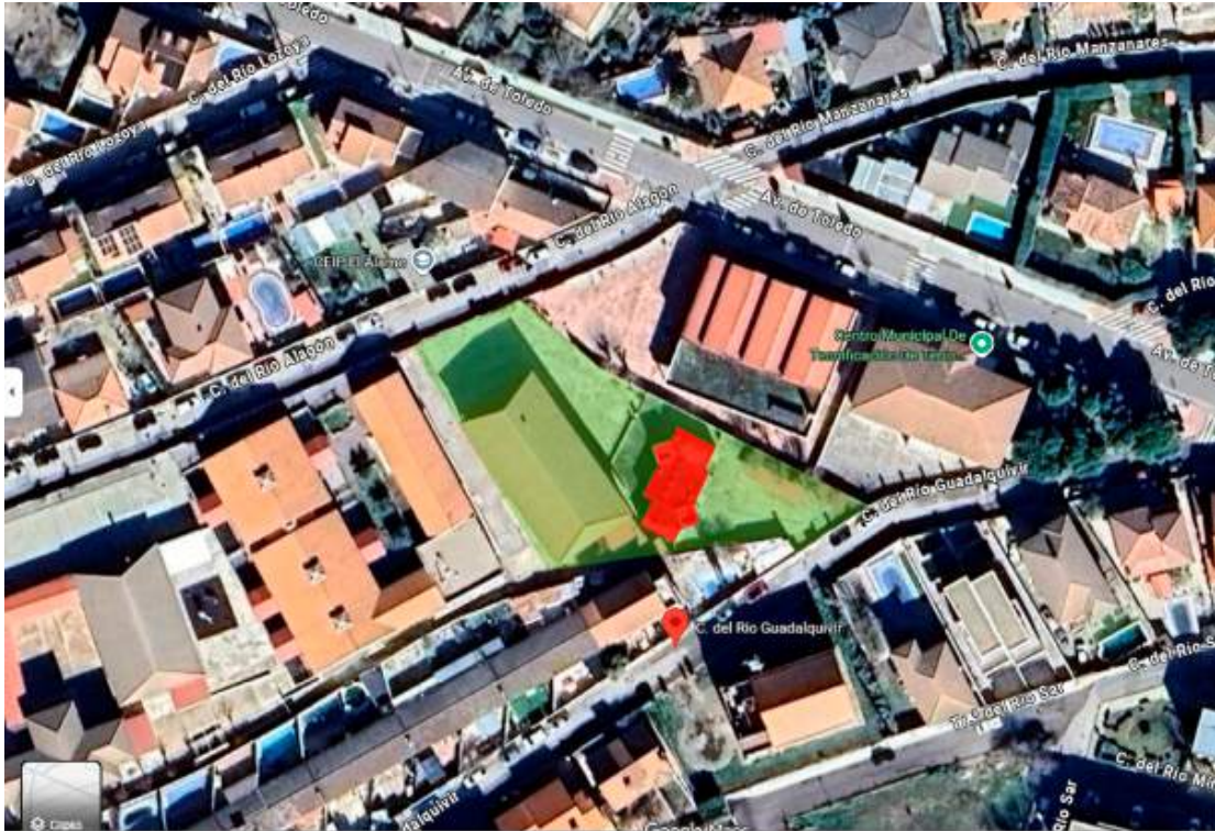
Ubicación de la parcela y el edificio dentro de la trama urbana de El Álamo
