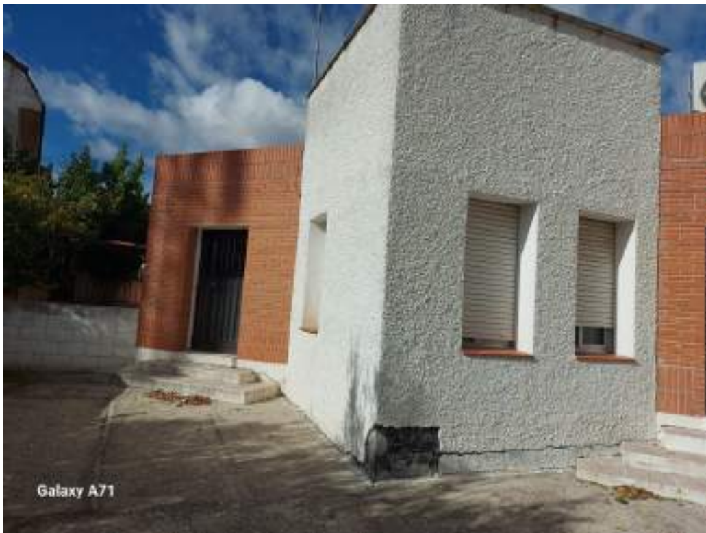
Vista estado conservación Fachada Principal
